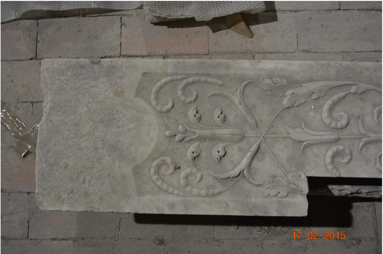
Repertorio 9 – Particolare della porzione frontale dell'architrave vista dal basso (elemento 5).
